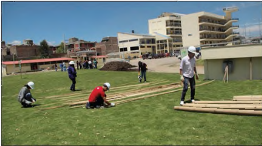
Figura N° 5A: Construcción de la estructura del parabolóide hiperbólico.
