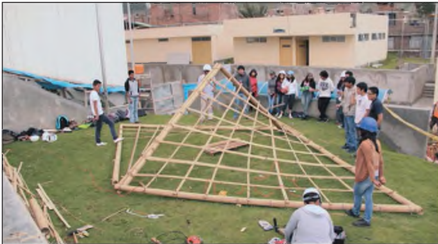
Figura N° 5B: Construcción de la estructura del parabolóide hiperbólico.
