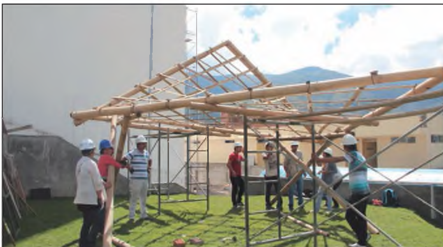
Figura N° 5C: Construcción de la estructura del parabolóide hiperbólico.
