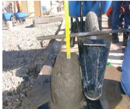
Figura 10. Asentamiento del concreto de 5 ½»
